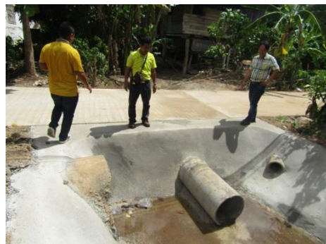
ก่อสร้างรางระบายน้ำคอนกรีตเสริมเหล็ก /วางท่อระบายน้ำ
