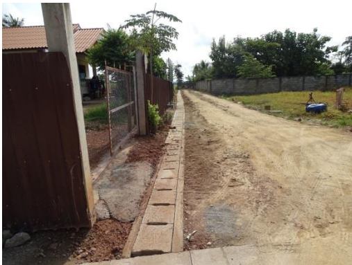
ก่อสร้างรางระบายน้ำคอนกรีตเสริมเหล็ก /วางท่อระบายน้ำ
